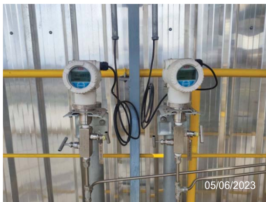
รูปที่ 77 อุปกรณ์ตรวจวัดอัตราการไหล ของหม้อไอน้ำ
