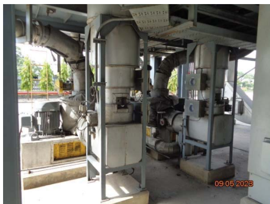
รูปที่ 7 ระบบควบคุม \text{SO}_2 และ \text{HCl} แบบ Dry-absorption System
