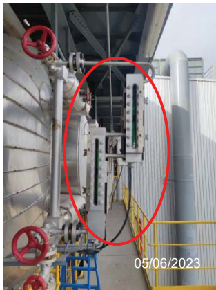
รูปที่ 79 อุปกรณ์ตรวจวัดระดับน้ำของหม้อไอน้ำ
