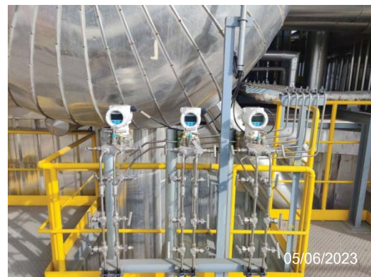
รูปที่ 76 อุปกรณ์ตรวจวัดความดันของหม้อไอน้ำ
