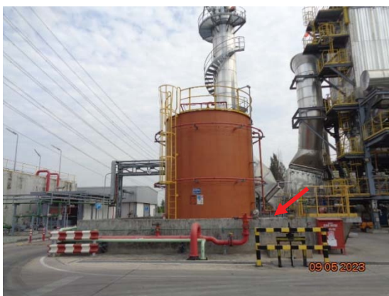
รูปที่ 42 คันคอนกรีตรอบถังเก็บสำรองน้ำมัน
