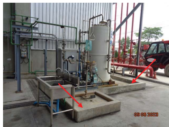
รูปที่ 43 คันคอนกรีตรอบถังบรรจุสารเคมี
