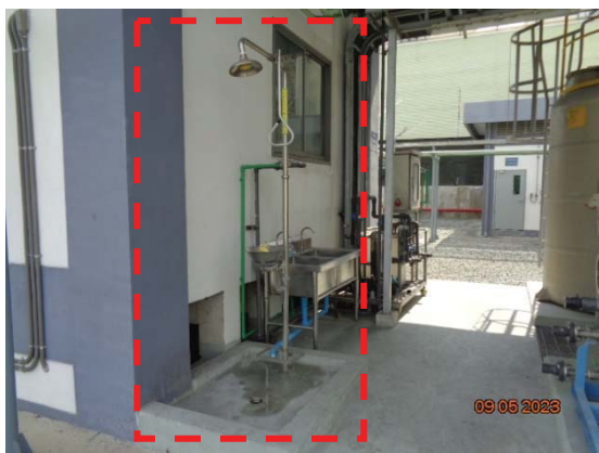
รูปที่ 75 ฝักบัวฉุกเฉินและอ่างล้างตา บริเวณพื้นที่เก็บสารเคมี
